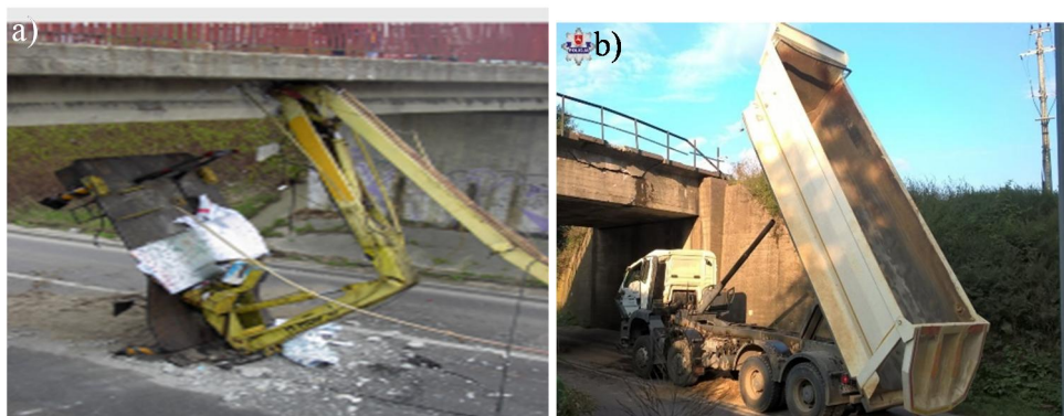
Rys. 20. Inne przykłady uderzeń: a) Uderzenie w spód konstrukcji przewożonym podnośnikiem koszowym – transport o ponadnormatywnej wysokości. Kładka dla pieszych nad Aleją Armii Krajowej w Gdańsku (fot. K. Żółtowski); b) Uderzenie w bok wiaduktu w Piotrowicach k/Nałęczowa, 31 sierpnia 2018 roku – kierowca zapomniał opuścić skrzynię ładunkową [40].
