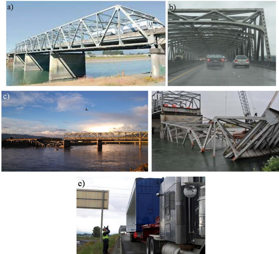
Rys. 18. Most Skagit: a) przed katastrofą – widok boczny; b) wnętrze mostu – widać wykrąglone stężenia górne; c) i d) skutki uderzenia ładunku w te stężenia; e) ładunek z wgnieciem od uderzenia w konstrukcję [38].
