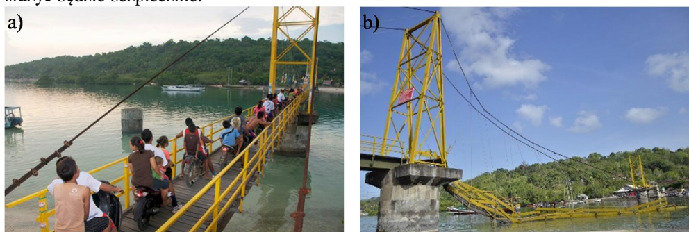
Rys. 12. Kładka dla pieszych Yellow Love: a) przed katastrofą; b) po katastrofie [29].
