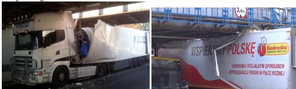
Rys. 21. Wiadukty kolejowe w Słupsku o obniżonej wysokości skrajni ruchu [42].
