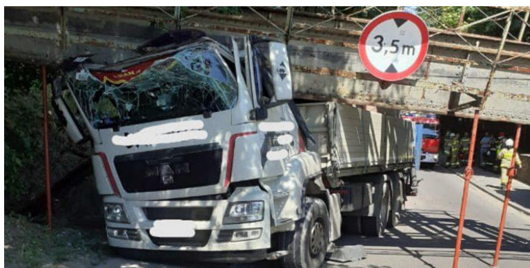
Rys. 21. Zawalenie przęsła wiaduktu kolejowego w Sierakowie, 13 lipca 2021 roku [41].
