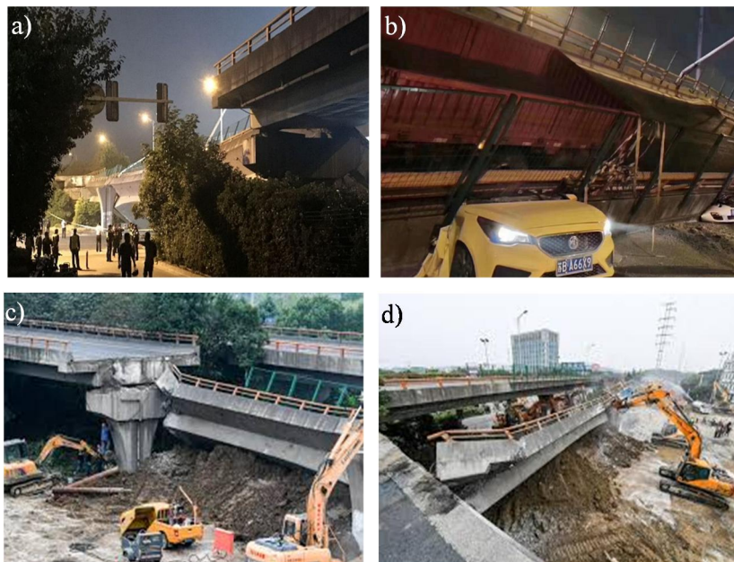
Rys. 14. Wiadukt Wuxi: a) i b) skutki katastrofy; c) i d) usuwanie jej skutków [32].
