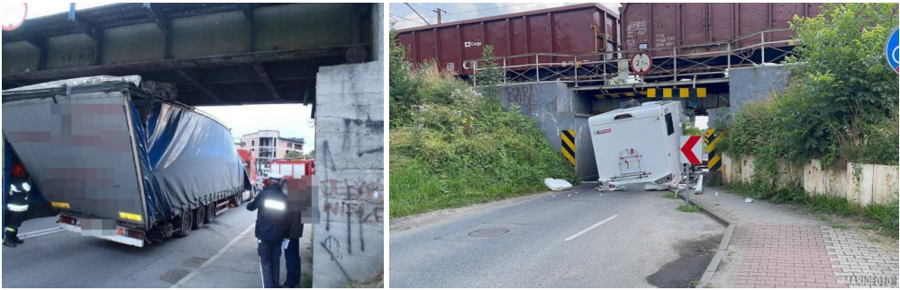
Rys. 22. a) Uderzenie pojazdu ciężarowego w spód wiaduktu kolejowego w Nowym Sączu [42]; b) uderzenie wiozonego nowego „kampera” w wiadukt kolejowy nad ul. Krapkowicką w Opolu, 26 lipca 2021 roku [43].
