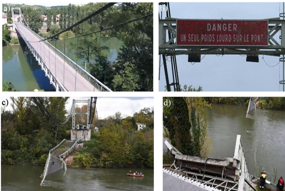
Rys. 15. Katastrofa mostu de Mirepoix przez rzekę Tarn, koło Tuluzy, Francja: a) most przed katastrofą; b) tablica z ostrzeżeniem („Uwaga niebezpieczeństwo – Tylko jeden samochód ciężarowy na moście”); c), d) skutki katastrofy [33].
